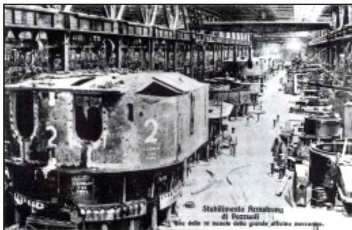
Veduta dell'interno dello stabilimento Armstrong di Pozzuoli (NA), nel settore in cui venivano prodotti cannoni di medio calibro per uso navale (1907). In primo piano è riconoscibile una torre da 190 mm destinata all'incrociatore corazzato San Giorgio. (Collezione Autore)
