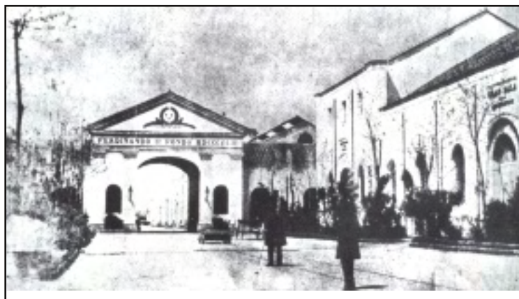
Il viale principale dell'opificio di Pietrarsa; di fronte si può notare l'arco evocativo dedicato al fondatore dello stabilimento e sulla destra l'edificio della "Gran sala delle costruzioni" (1859). (Collezione Autore)
