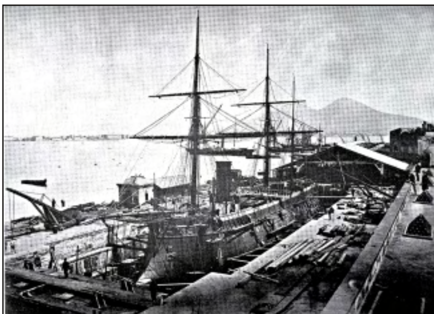
La cannoniera corazzata Varese sottoposta a lavori di manutenzione allo scafo nel "Bacino da Raddobbo" di Napoli nel 1869. (Collezione Autore)
